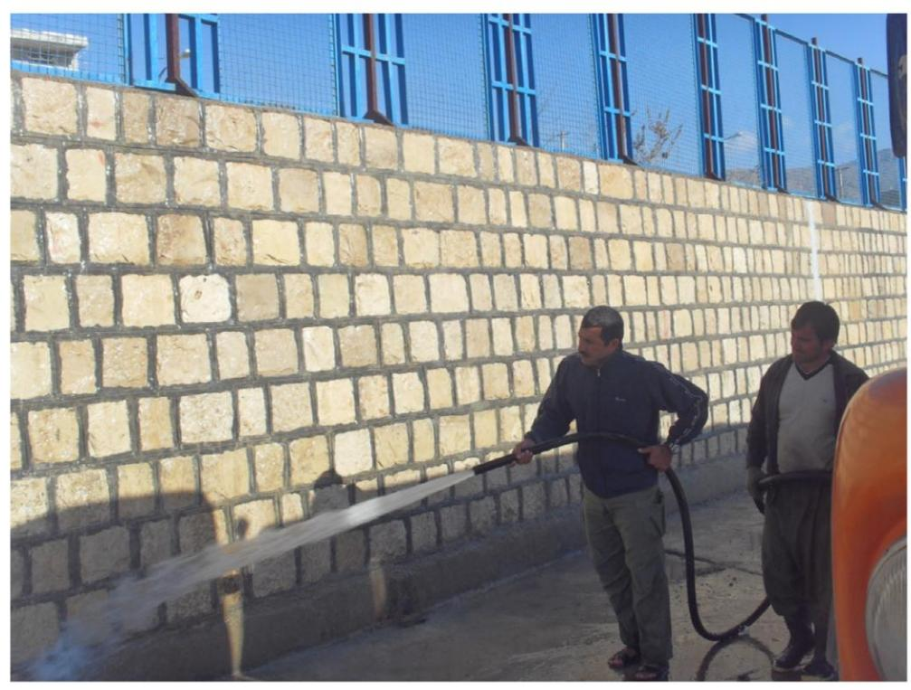
پس از شستشوی دیوار تمام بندکشی هایی که به علت عدم اجرای مناسب دارای خلل و فرج، ترک و حفره بودند با استفاده از ماده ترمیم کننده ویژه E.M.SUPER REPAIR ترمیم و آماده اجرای پوشش نهایی لایه آب بند گردیدند.
