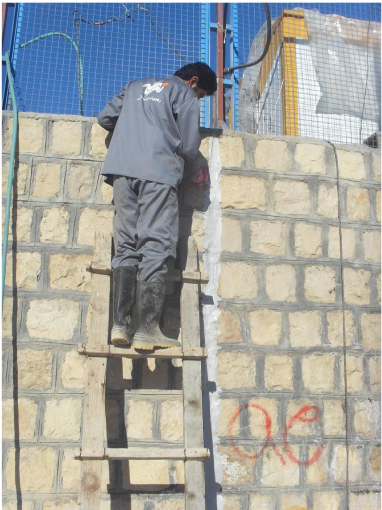
۵- پر کردن درزهای کف دریاچه با استفاده از ماسه آسفالت
